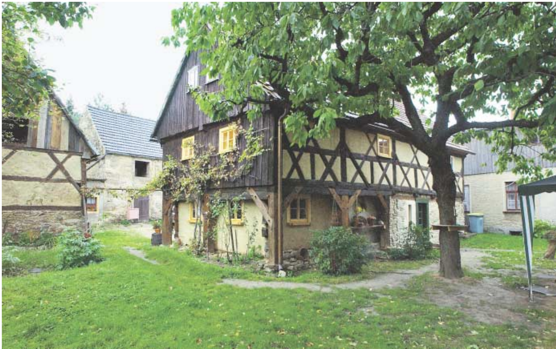
Vor dem Verfall gerettet: das Umgebäudehaus von Arnd Matthes im kleinen Weiler Waditz in der Nähe von Bautzen.
