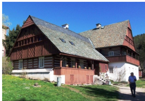
Abb. B-120 kurze Oberlaube nur über traufseitigem Eingangsbereich (Dobřeň) / Abb. B-121 und Abb. B-122 dreiseitig umlaufender Gang vor zurückgesetzten Oberstockwänden, weiter Traufüberstand zusätzliches Vordach auf der Giebelseite (Bělišťe, Stadtmuseum Železný Brod)
