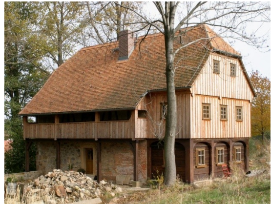
Abb. B-129 und Abb. B-130 Trauf- und Giebelansicht einer Kreuzstube über einer Vorlaube (Hirschfelde) / Abb. B-131 gemeinsamer Vorlaubengang vor Giebel- bzw. Traufseite zweier benachbarter Häuser (Schirgiswalde)
