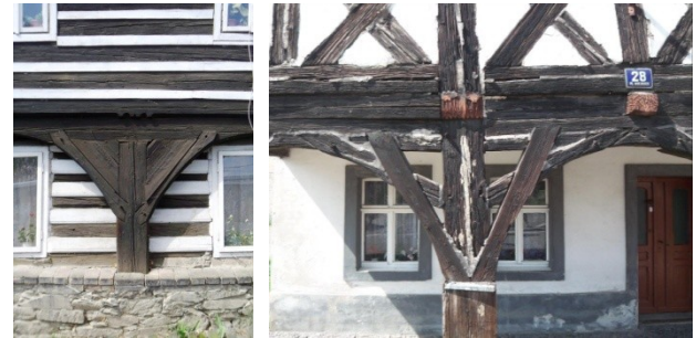
Abb. B-66 (rechts) Kopfband, ausgeklotzt (Soběnice) / Scherenkopfband an Langständer (Sulikow, PL)
