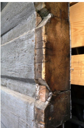
Abb. B-85 in Bohlenwand eingelegte Dreiecksleisten (Lipová)
