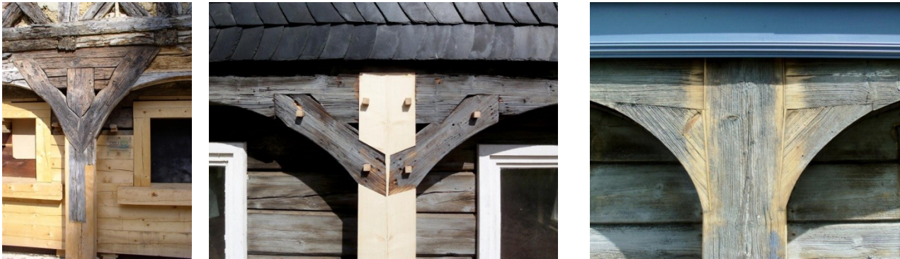
Abb. B-78 aufwändig angeblatteter Feldständer (Foto: A. Matthes) / Abb. B-79 neuer Feldständer an vorhandene Kopfbänder angepasst und mit neuen Holznägeln gesichert / Abb. B-80 Fugen präzise ausgespant
