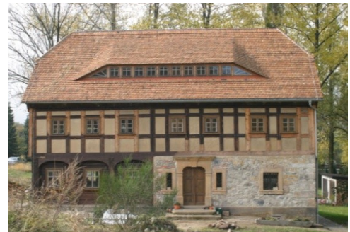
Abb. B-112 Jonsdorf, nach der Sanierung
