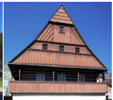
Abb. B-120 kurze Oberlaube nur über traufseitigem Eingangsbereich (Dobřeň) / Abb. B-121 und Abb. B-122 dreiseitig umlaufender Gang vor zurückgesetzten Oberstockwänden, weiter Traufüberstand zusätzliches Vordach auf der Giebelseite (Bělišťe, Stadtmuseum Železný Brod)
