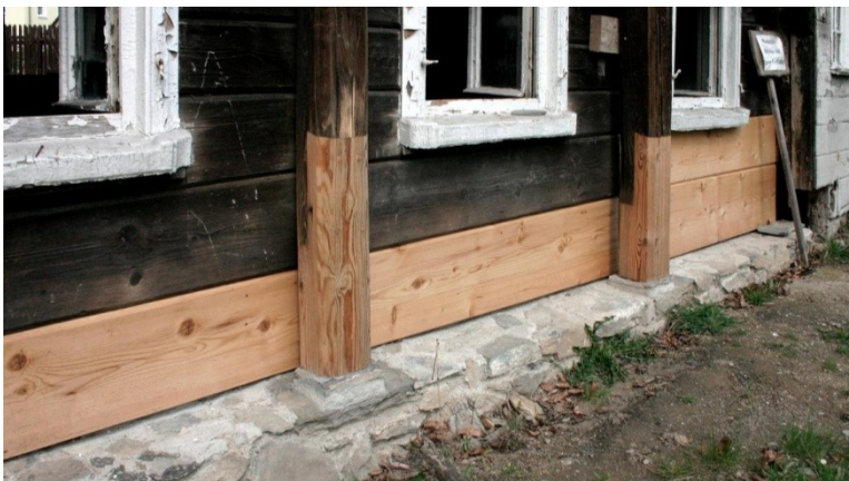
Abb. B-94 untere Blockbohle erneuert (Seifhennersdorf)
