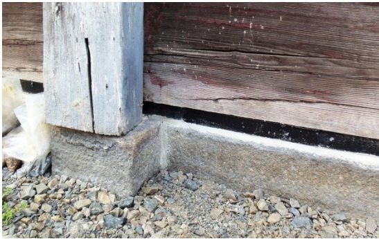
Abb. B-95 Schaumglasplatte als Trennschicht („Pilgerhäusl“, Hirschfelde)
