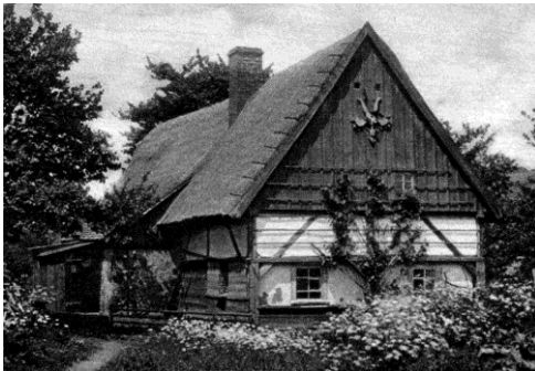
Abb. B-99 Langständer, 1 ½-geschossig, nur einzelne Kopfstreben (Cunewalde, Archiv Beelitz, Ausschnitt) / Abb. B-100 Stockwerkbau, einfacher Fachwerkkorb im Oberstock (Siebitz) / Abb. B-101 rechts: reich gegliedertes Fachwerk mit Andreaskreuzen und Gitterwerk (Karpniki, PL)
