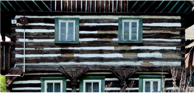
Abb. B-92 Abplatzen der wetterschützenden Putzschrift über Lehmverstrich
