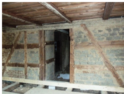
Abb. B-102 Flurzone und zweite Stube (oder Kammer) als Fachwerkkonstruktion (Neuschirgiswalde) / Abb. B-103 aussteifende Querwand mit Ziegel und Steinausfachung / Abb. B-104 Seitenflur, tragende Längswände
