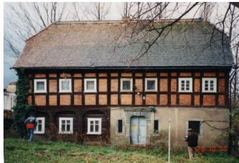
Abb. B-113 Jonsdorf, vor der Sanierung (Foto: Schreiber)
