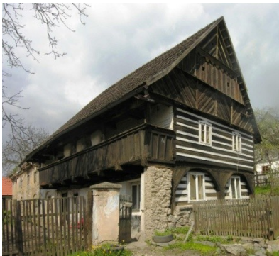
Abb. B-117 und Abb. B-118 Oberlauben über die gesamte Hauslänge unter weitem Dachüberstand (Soběnice und Museum Dolánky) / Abb. B-119 „Innen“ansicht (Museum Dolánky)
