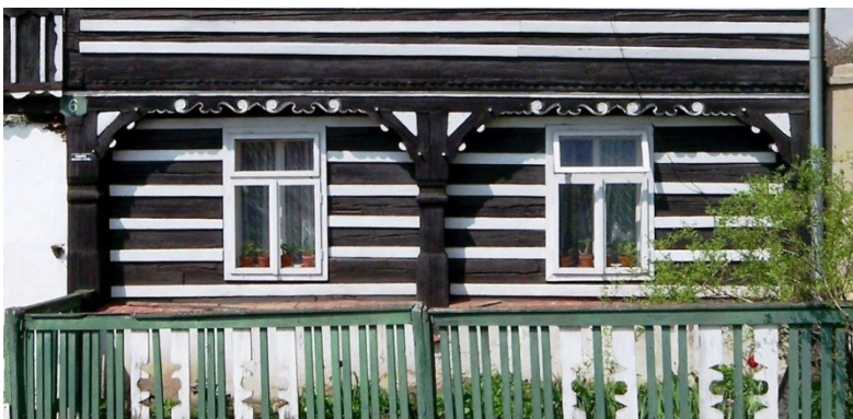
Abb. B-67 (oben links): nicht profilierte Ständer, aufgeblattete gerade Kopfbänder, gerader Spannriegel mit geringer Ausnehmung (Sebnitz)
