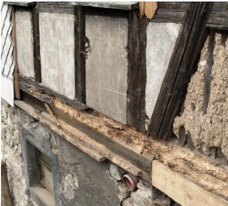
Abb. B-108 und Abb. B-109 Nach Abnahme der Verkleidung entdeckt: links: Fachwerkschwelle durch Feuchte und anschließenden Insektenbefall stark angegriffen /rechts: Schadstellen an Fensterstielen im Bereich der Fensterbretter, bereits ältere Behelfsreparatur mit Ziegel erkennbar
