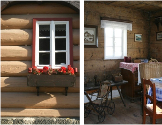
Abb. B-84 Blockwand aus 4-seitig beeilten halbierten Stämmen, tiefe Baumkanten außen, innen ebene Fläche des halbierten Stammes (Schöna)
