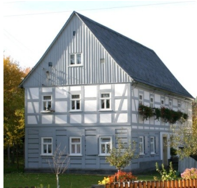
Abb. B-63 Ständerbohlenstube in Cunnnersdorf, Sächsische Schweiz (oder aus-geblocktes Fachwerk?)
