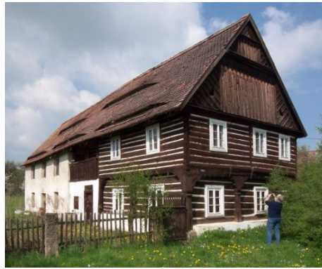
Abb. B-115 in die traufseitige Wand „eingelassene“ kurze Laube im Oberstock (Lhota) / Abb. B-116 auskragende Oberlaube über dem Massivteil in halber Traufseitenlänge unter großem Dachüberstand (Lhota)
