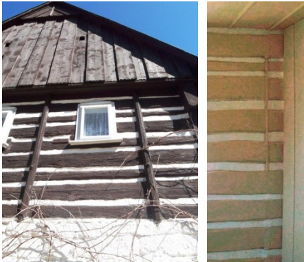
Abb. B-64 „Schraubstiele“ (Wandzangen) in Malá Skála
