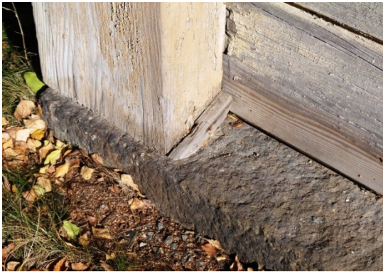
Abb. B-96 Stützschiene für Sockelbrett
