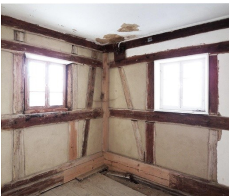
Abb. B-110 fachgerechte Reparatur von Umgebinderähm, Fachwerkschwelle und Fachwerkständerfüßen (Halbendorf)
