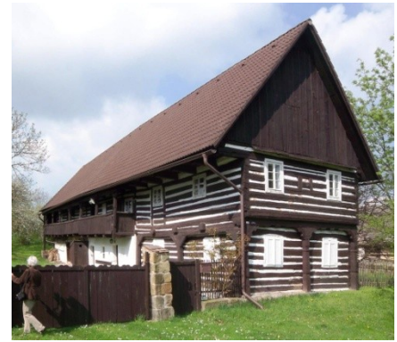
Abb. B-115 in die traufseitige Wand „eingelassene“ kurze Laube im Oberstock (Lhota) / Abb. B-116 auskragende Oberlaube über dem Massivteil in halber Traufseitenlänge unter großem Dachüberstand (Lhota)
