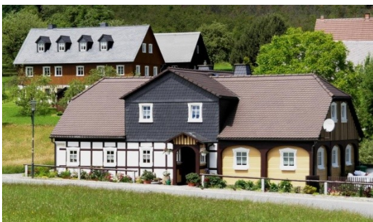
Abb. B-102 Flurzone und zweite Stube (oder Kammer) als Fachwerkkonstruktion (Neuschirgiswalde) / Abb. B-103 aussteifende Querwand mit Ziegel und Steinausfachung / Abb. B-104 Seitenflur, tragende Längswände
