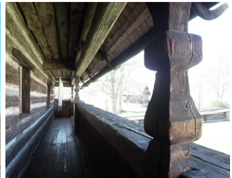
Abb. B-117 und Abb. B-118 Oberlauben über die gesamte Hauslänge unter weitem Dachüberstand (Soběnice und Museum Dolánky) / Abb. B-119 „Innen“ansicht (Museum Dolánky)
