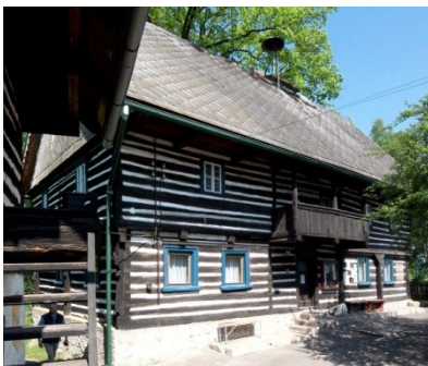
Abb. B-120 kurze Oberlaube nur über traufseitigem Eingangsbereich (Dobřeň) / Abb. B-121 und Abb. B-122 dreiseitig umlaufender Gang vor zurückgesetzten Oberstockwänden, weiter Traufüberstand zusätzliches Vordach auf der Giebelseite (Bělišťe, Stadtmuseum Železný Brod)
