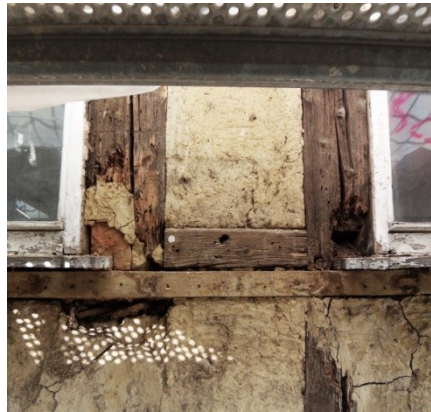
Abb. B-108 und Abb. B-109 Nach Abnahme der Verkleidung entdeckt: links: Fachwerkschwelle durch Feuchte und anschließenden Insektenbefall stark angegriffen /rechts: Schadstellen an Fensterstielen im Bereich der Fensterbretter, bereits ältere Behelfsreparatur mit Ziegel erkennbar
