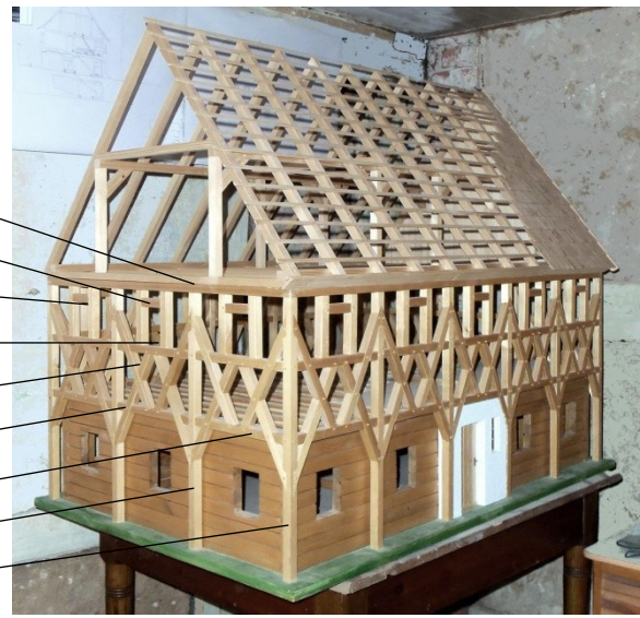
Abb. B-102 Flurzone und zweite Stube (oder Kammer) als Fachwerkkonstruktion (Neuschirgiswalde) / Abb. B-103 aussteifende Querwand mit Ziegel und Steinausfachung / Abb. B-104 Seitenflur, tragende Längswände
