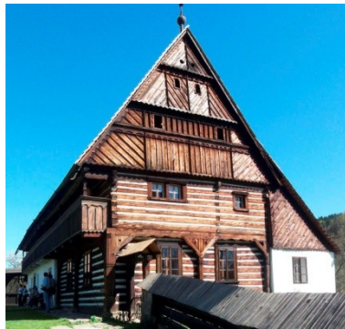
Abb. B-117 und Abb. B-118 Oberlauben über die gesamte Hauslänge unter weitem Dachüberstand (Soběnice und Museum Dolánky) / Abb. B-119 „Innen“ansicht (Museum Dolánky)
