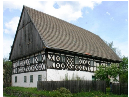
Abb. B-99 Langständer, 1 ½-geschossig, nur einzelne Kopfstreben (Cunewalde, Archiv Beelitz, Ausschnitt) / Abb. B-100 Stockwerkbau, einfacher Fachwerkkorb im Oberstock (Siebitz) / Abb. B-101 rechts: reich gegliedertes Fachwerk mit Andreaskreuzen und Gitterwerk (Karpniki, PL)
