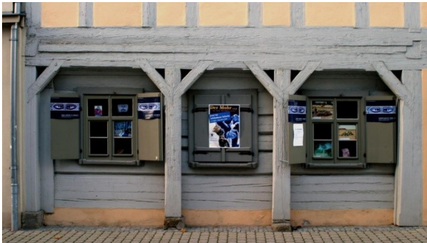
Abb. B-66 (rechts) Kopfband, ausgeklotzt (Soběnice) / Scherenkopfband an Langständer (Sulikow, PL)
