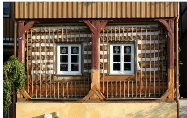
Abb. B-78 aufwändig angeblatteter Feldständer (Foto: A. Matthes) / Abb. B-79 neuer Feldständer an vorhandene Kopfbänder angepasst und mit neuen Holznägeln gesichert / Abb. B-80 Fugen präzise ausgespant
