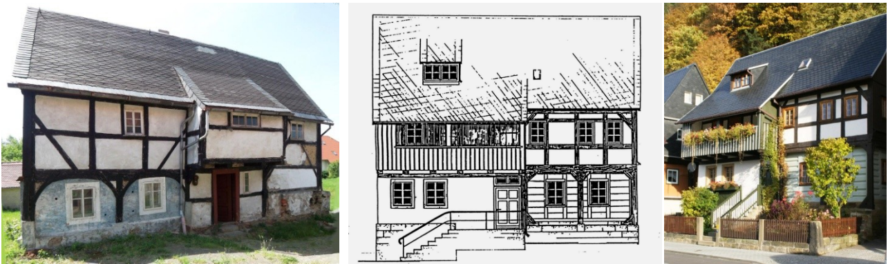
Abb. B-126 geschlossene ausgebaute Oberlaube über Eingangsbereich (Meschwitz) / Abb. B-127 und Abb. B-128 offene Oberlaube über Eingang und Massivteil (Postelwitz, Zeichnung: H. Lommatzsch)
