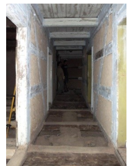
Abb. B-102 Flurzone und zweite Stube (oder Kammer) als Fachwerkkonstruktion (Neuschirgiswalde) / Abb. B-103 aussteifende Querwand mit Ziegel und Steinausfachung / Abb. B-104 Seitenflur, tragende Längswände
