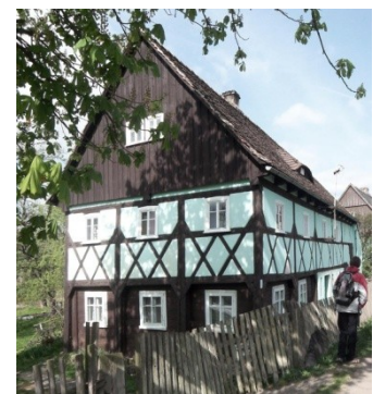
Abb. B-49 Langständerbau (Grundlage der bearbeiteten Zeichnung: Deutschmann, E. (1959). Lausitzer Holzbaukunst . Bautzen: VEB Domowina Verlag., Tafel 17, S. 179, Zeichnung Prof. E. Deutschmann)
