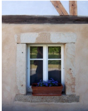
Abb. B-39 einfache Öffnungsfassung mit Bruchsteinplatten (Kleinkunitz)
