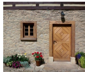
Abb. B-32 Steinsichtigkeit eines Feldsteinmauerwerkes / Abb. B-33 Sandsteinmauerwerk, durch weiten Dachüberstand geschützt (ein ehemaliger Verputz ist anhand der hervortretenden Gewändeausbildung zu vermuten) / Abb. B-34 neue Steinsichtigkeit des kleinteiligen Natursteinmauerwerkes nach der Sanierung
