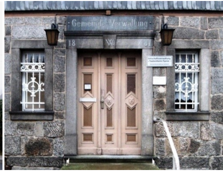
Abb. B-26 und Abb. B-27 ehemaliges Gemeindeamt in Taubenheim, 1881 erbaut, mit bauzeitlichem unregelmäßigem Granitsichtmauerwerk
