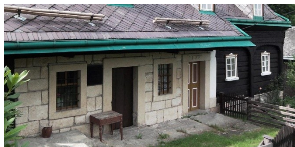
Abb. B-32 Steinsichtigkeit eines Feldsteinmauerwerkes / Abb. B-33 Sandsteinmauerwerk, durch weiten Dachüberstand geschützt (ein ehemaliger Verputz ist anhand der hervortretenden Gewändeausbildung zu vermuten) / Abb. B-34 neue Steinsichtigkeit des kleinteiligen Natursteinmauerwerkes nach der Sanierung
