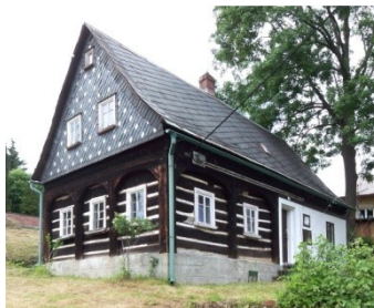
Abb. B-53 Stockwerksbau (Grundlage der bearbeiteten Zeichnung: Deutschmann, E. (1959). Lausitzer Holzbaukunst . Bautzen: VEB Domowina Verlag., Tafel 17, S. 179, Zeichnung Prof. E. Deutschmann)
