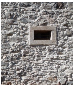
Abb. B-32 Steinsichtigkeit eines Feldsteinmauerwerkes / Abb. B-33 Sandsteinmauerwerk, durch weiten Dachüberstand geschützt (ein ehemaliger Verputz ist anhand der hervortretenden Gewändeausbildung zu vermuten) / Abb. B-34 neue Steinsichtigkeit des kleinteiligen Natursteinmauerwerkes nach der Sanierung
