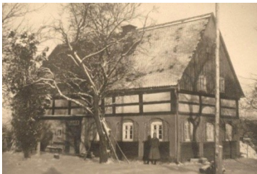
Abb. B-58 Stockwerksbau mit Drempel (Archiv Richter) / Abb. B-59 Langständer(neu)bau mit Drempel (Jindřichovice) / Abb. B-60 „Umschrot“ (Kryštofovo údolí)
