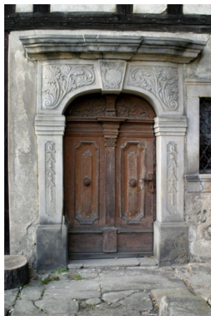
Abb. B-40 einfaches Fenstergewände aus Granit (Weifa) / Abb. B-41 Sandsteingewände, Granitsohlbank (Ohorn) / Abb. B-42 gegliederter Granittürstock / Abb. B-43 reich ornamentierter Sandsteintürstock (Großschönau)
