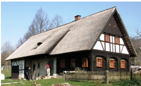
Abb. B-53 Stockwerksbau (Grundlage der bearbeiteten Zeichnung: Deutschmann, E. (1959). Lausitzer Holzbaukunst . Bautzen: VEB Domowina Verlag., Tafel 17, S. 179, Zeichnung Prof. E. Deutschmann)
