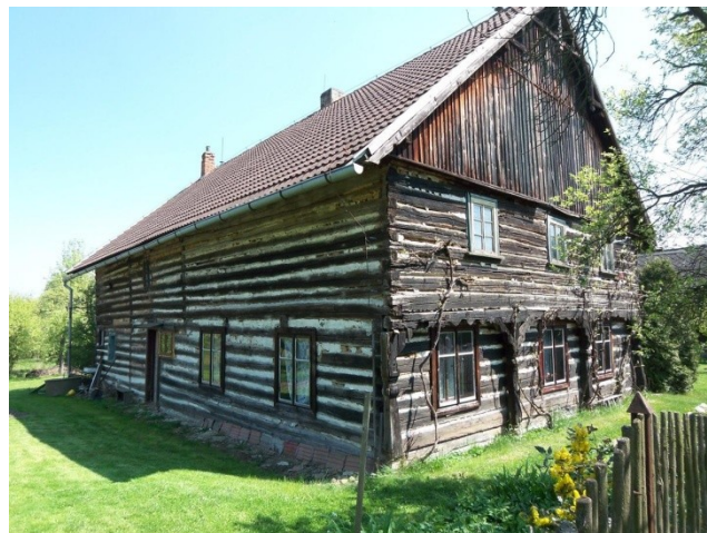
Abb. B-62 traufseitige Stützkonstruktion ( Traufgebäude ) in Hrubá Horka
