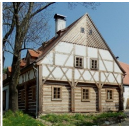
Abb. B-58 Stockwerksbau mit Drempel (Archiv Richter) / Abb. B-59 Langständer(neu)bau mit Drempel (Jindřichovice) / Abb. B-60 „Umschrot“ (Kryštofovo údolí)
