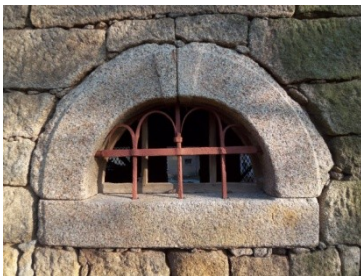
Abb. B-31 Fenstergewände mit Anschlagkante für den ursprünglichen Verputz an einem Stallgebäude
