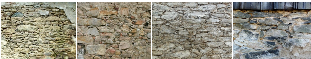
Abb. B-23 Natursteinmauerwerk aus Feld- oder Bruchsteinen (Granit, Sandstein, Grauwacke und Phonolith), ursprünglich verputzt
