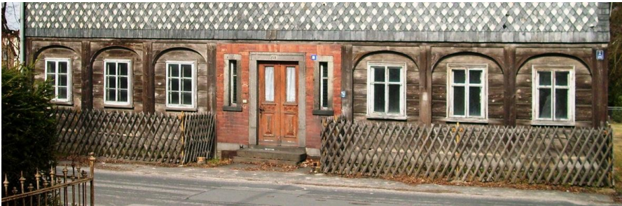
Abb. B-36 Klinkermauerwerk in Flurzone (Neugersdorf/Foto: J. Gosteli, Ausschnitt) / Abb. B-37 Klinkerverwendung im Eingangsbereich und als Umgebinderdesockel (Rumburk)
