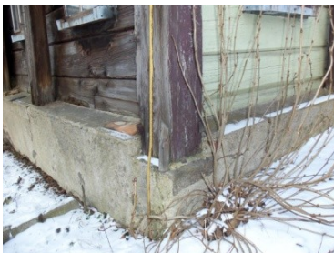
Abb. B-19 Sockelaufmauerung
