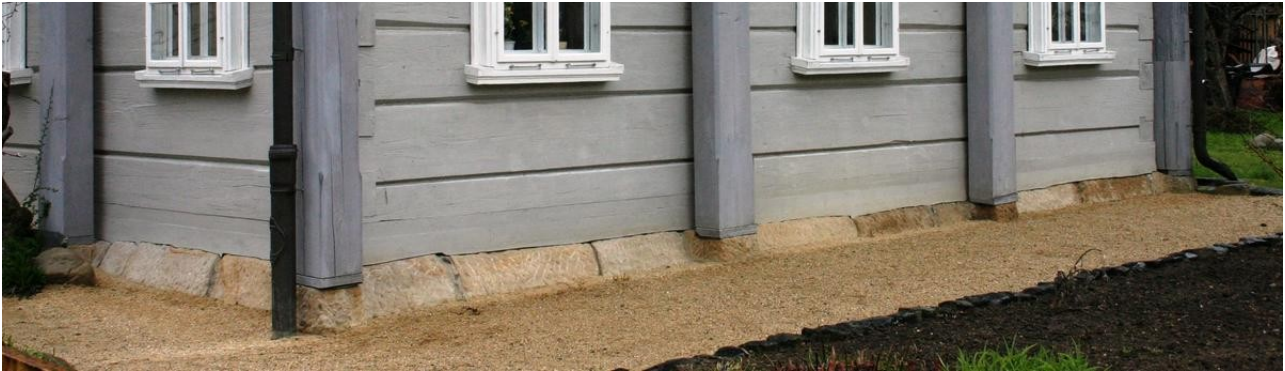
Abb. B-22 gereinigter Sandsteinsockel in selten gesehener Form: Der Sockel ist im Bereich der Joche zwar stubenbündig, dann aber nach außen geneigt; Schutz der Ständerfüße gegen aufsteigende Feuchte mit Eichenbrettstücken („Opferholz“, ca. 25 Jahre haltbar), (Großschönau)
